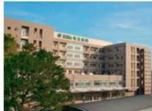
基幹施設 国立病院機構博崎玉病院 (2,3,4,5,6)
