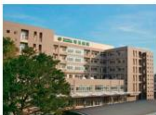
基幹施設 国立病院機構埼玉病院 (2,3,4,5,6)
