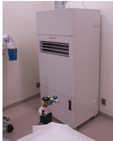
簡易陰圧装置を救急外来 4 台、救急病棟 6 台新規に設置
